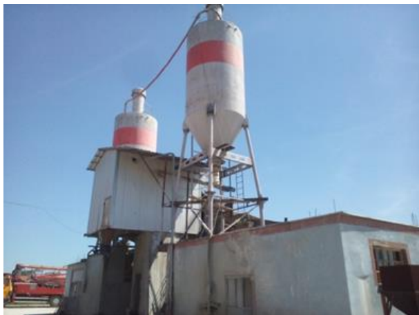
Silos za cement, miješalica i upravljačke kabine
