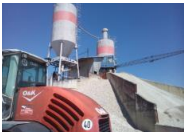
Silos za cement, boksovi za kameni agregat i bager sajlaš
