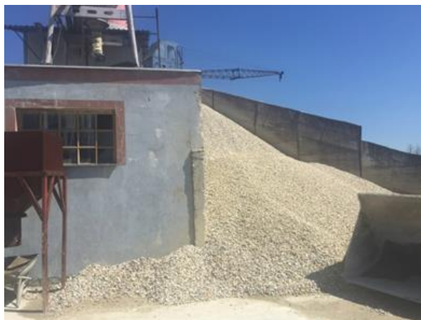
Upravljačka kabina i boks za kameni agregat
