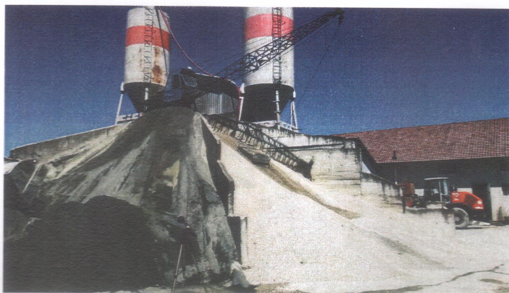
Slika 2. Rad proizvodnog pogona betonare tipa „zvijezda“
