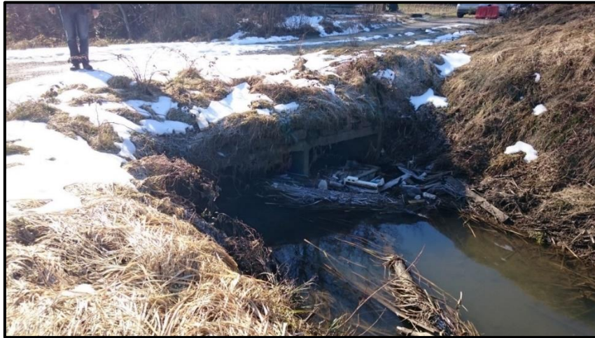
Slika 2.1-5. Stanje propusta PR3 (stac. km 1+776,8), pogled uzvodno (izvor: Institut IGH d.d., 2017.)
