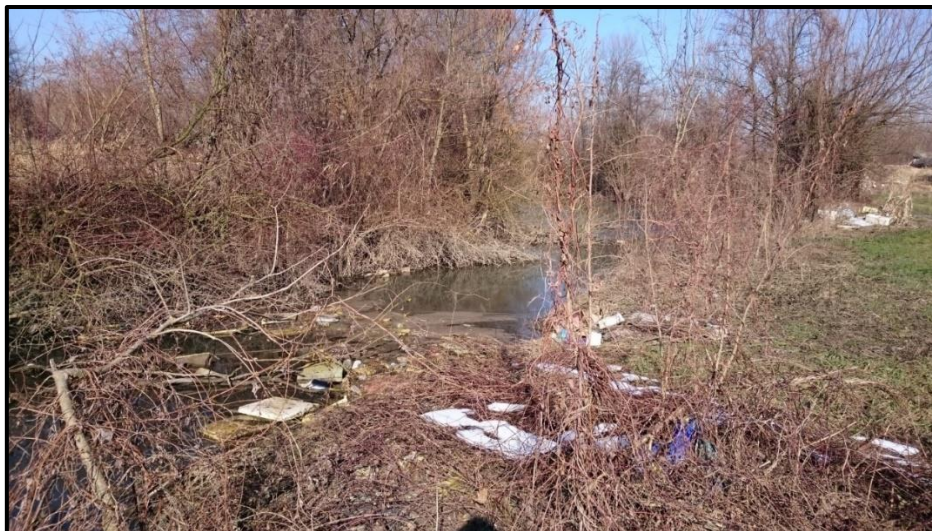
Slika 2.1-3. Karakteristično stanje korita vodotoka Goštiraj na dionici od km 1+491,38 do km 2+297,33 (izvor: Institut IGH d.d., 2017.)
