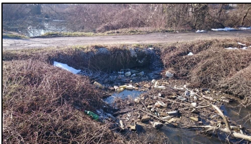
Slika 2.1-4. Stanje propusta PR2 (stac. km 1+776,8), pogled uzvodno (izvor: Institut IGH d.d., 2017.)
