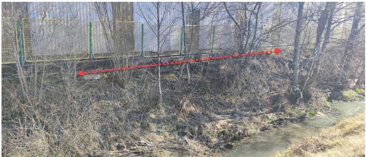
Slika 2-4. Podlokavanje ograde uslijed erozije (sredina dionice).
