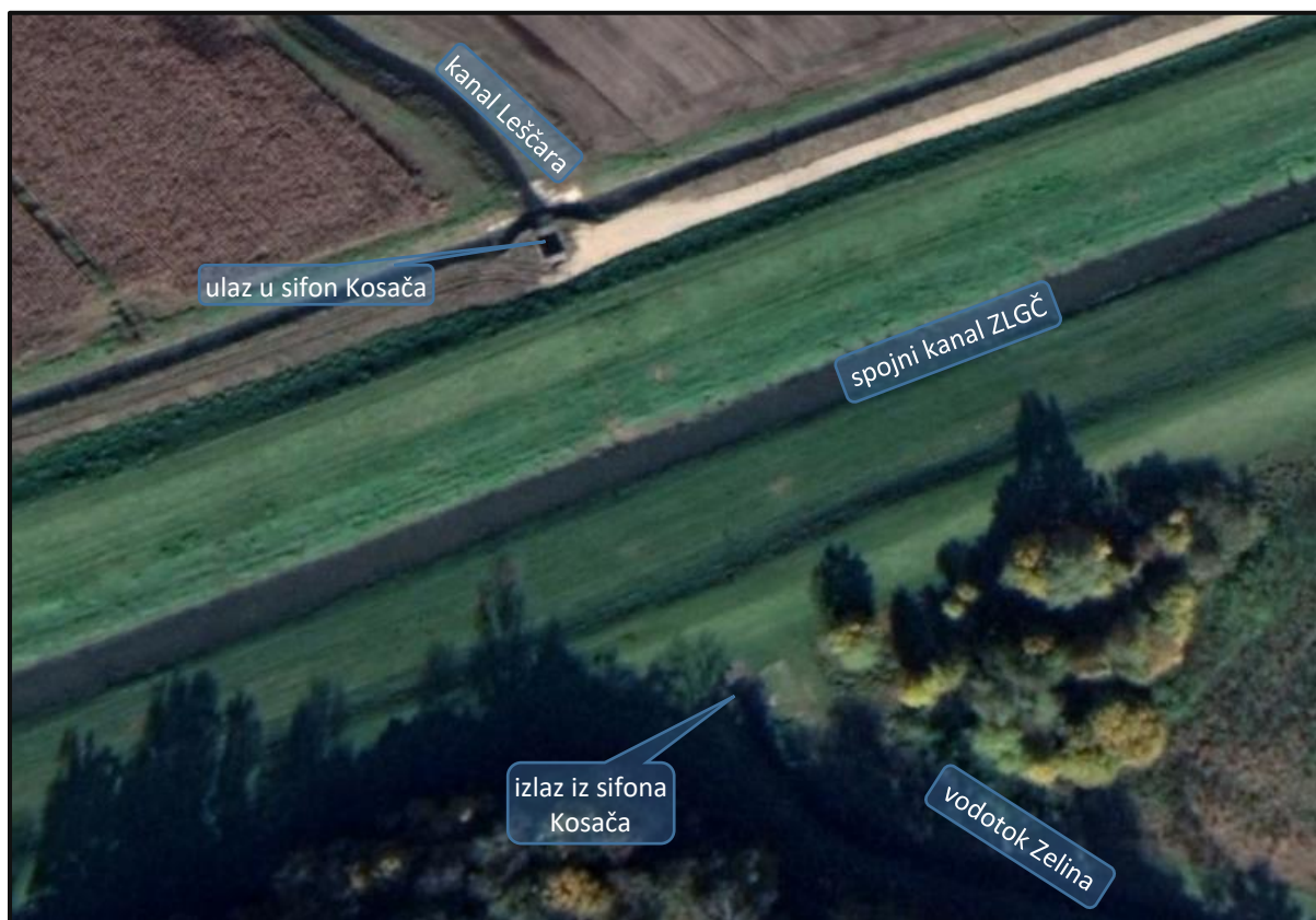
Slika 2.1-2. Postojeći sifon Kosača: pogled iz zraka (izvor: Google Earth, 2021.)
