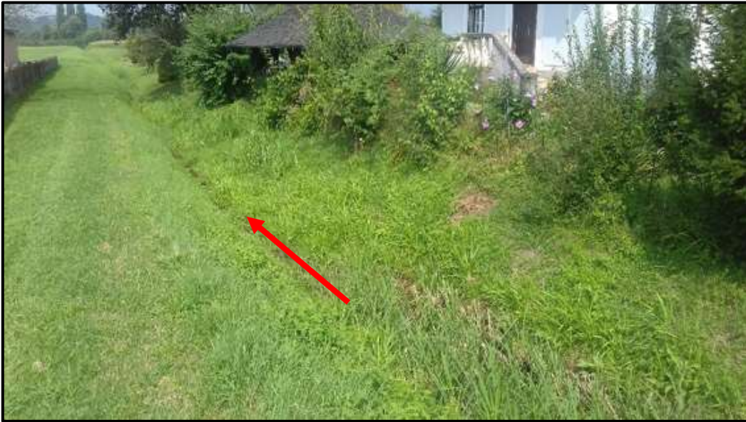
Slika 2.1-2. Predmetna dionica potoka Volovščak središnji dio prema početnoj stacionaži u km 0+210, s označenim smjerom tečenja (izvor: Viacon , 2019.)
