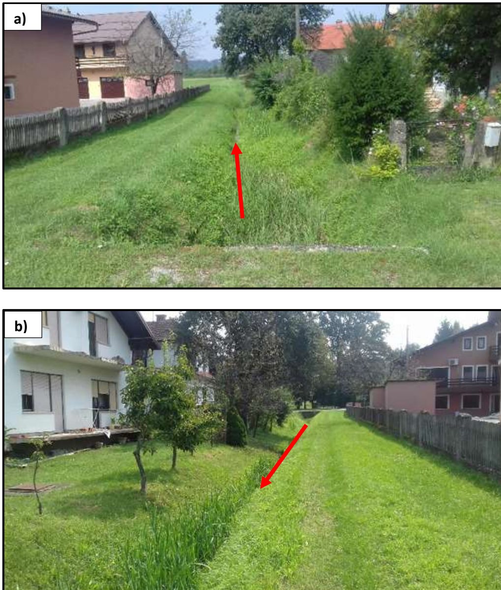
Slika 2.1-1. Predmetna dionica potoka Volovščak od završne stacionaže u km 0+290 (ŽC3005) nizvodno, s označenim smjerom tečenja: (a) pogled nizvodno od ŽC3005, i (b) pogled uzvodno prema ŽC3005 (izvor: Viacon, 2019. )
