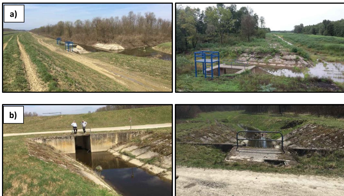
Slika 2.1-3. Građevine u zoni sifona Poljanski Lug: a) ulazna građevina, b) izlazna građevina (preuzeto iz: Hidroprojekt d.o.o., 2017.)
