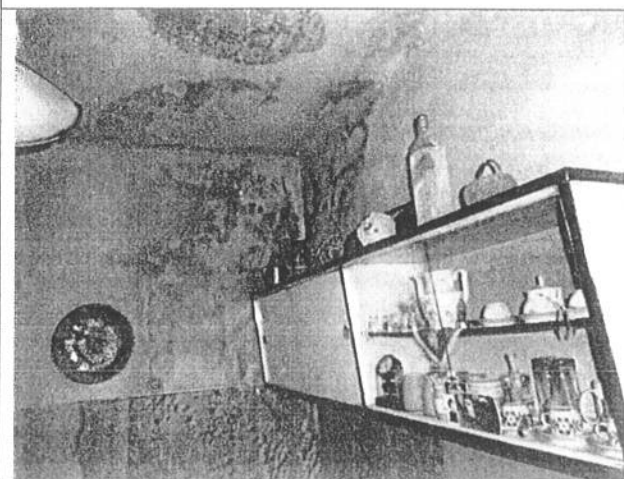
5. UNUTRAŠNJOST JEDNOG STANA
