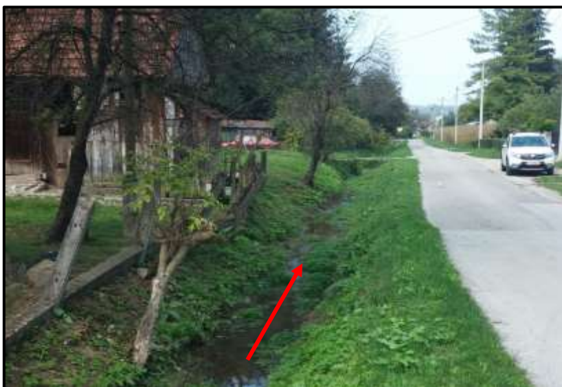
Slika 2.1-3. Pogled nizvodno prema cijevnom propustu u stac. km 0+729,51, s označenim smjerom tečenja (izvor: Viacon, 2019. )
