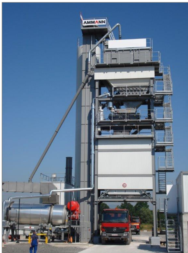
Slika 6. Otprema proizvedenog asfalta transportnim vozilima
