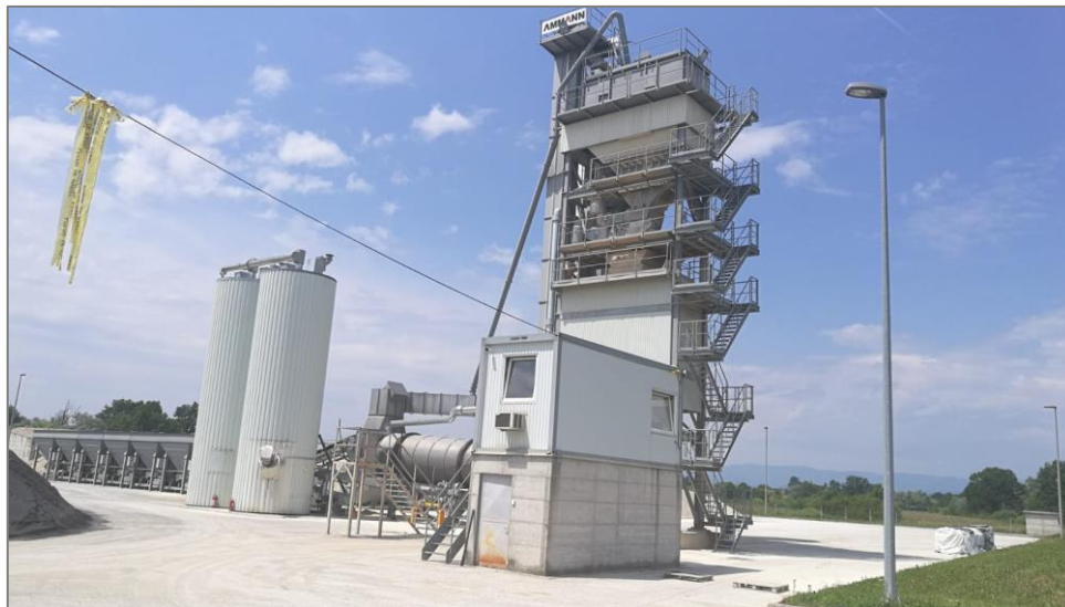
Slika 1. Postojeća asfaltna baza Banje Selo
