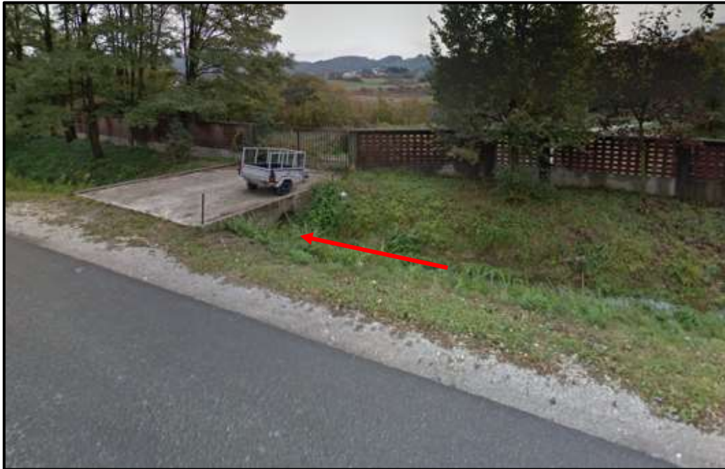
Slika 2.1-2. Propust na potoku Velika Rakovica na kolnom prijelazu između ulice Črešni i privatnog dvorišta (izvor: Viacon, 2019. )
