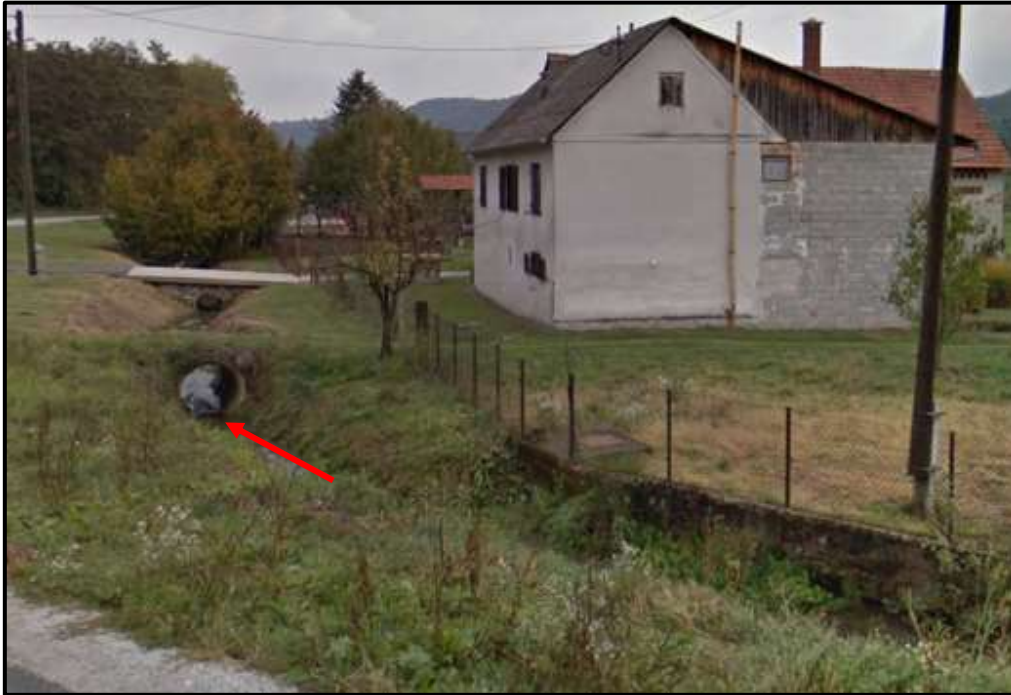
Slika 2.1-4. Korito potoka Velika Rakovica s izvedenim propustima na prilazima dvorištima u ulici Črešni (izvor: Viacon , 2019.)
