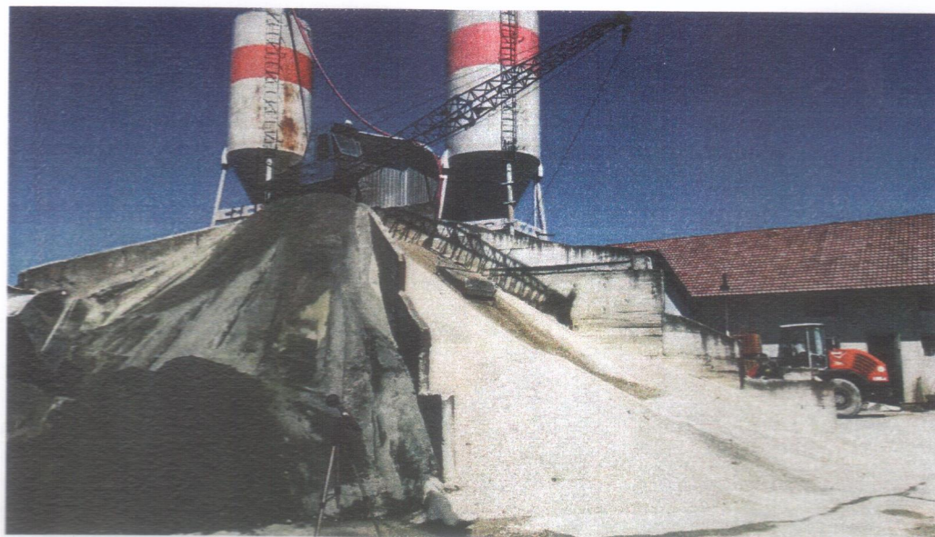
Slika 2. Rad proizvodnog pogona betonare tipa „zvijezda“
